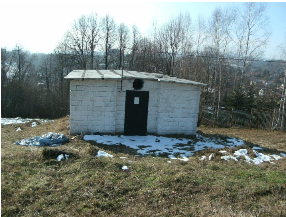
Fot. 9. Ohel w Gorlicach przed remontem
